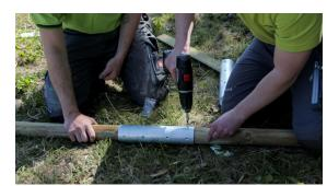
Schieben Sie die Holzelemente bis zur Mitte in die Verbindungshülsen und befestigen Sie diese mit den kurzen Schrauben.
