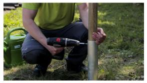
Stecken Sie die Ansitzstange in die mittlerweile feste Bodenhülse, schrauben sie diese mit den kurzen Schrauben fest und schließen Sie das Loch wieder mit Erde.
