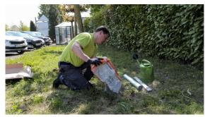
Befüllen Sie das Loch mit schnell härtendem Beton und hämmern Sie die lange Bodenhülse in den trockenen Beton. Richten sie die Bodenhülse senkrecht aus und übergießen Sie den Beton mit Wasser. Während dieser trocknet, kann der Zusammenbau der Ansitzstange beginnen.
